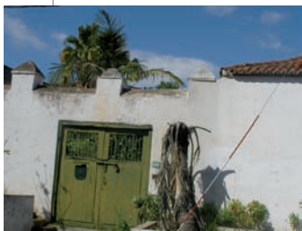
2.8 Portadas de almenadas en San Gonzalo (El Socorro)
