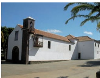
2:9 Iglesia de El Socorro
